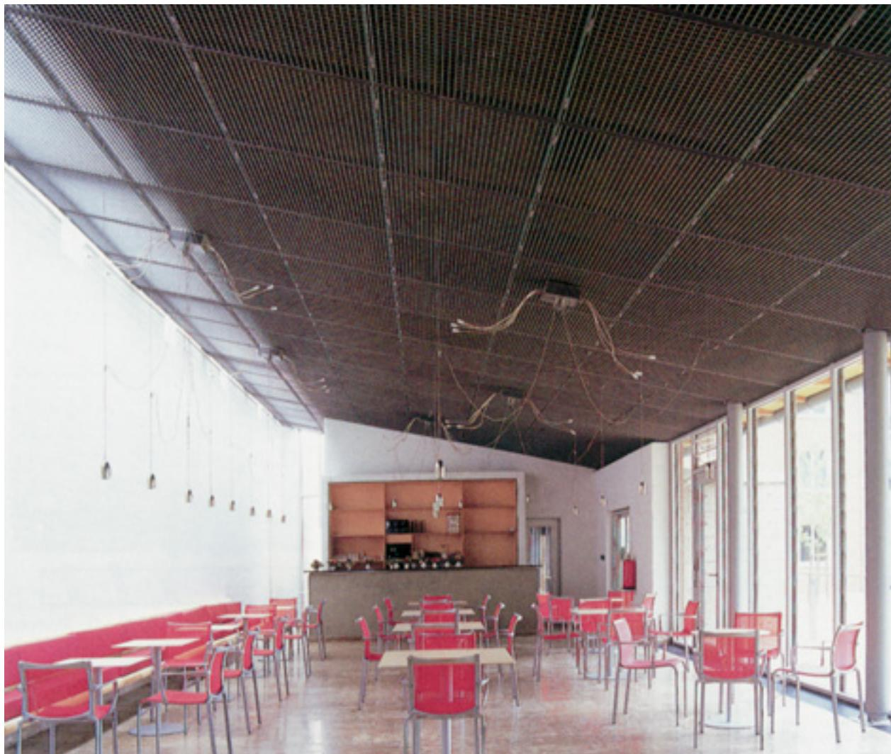
Täyspuristerilä (A) katossa. Kattopanelintyyppi kuvassa 66x66 / 60x3 (A) pulverimaalaattuna.
