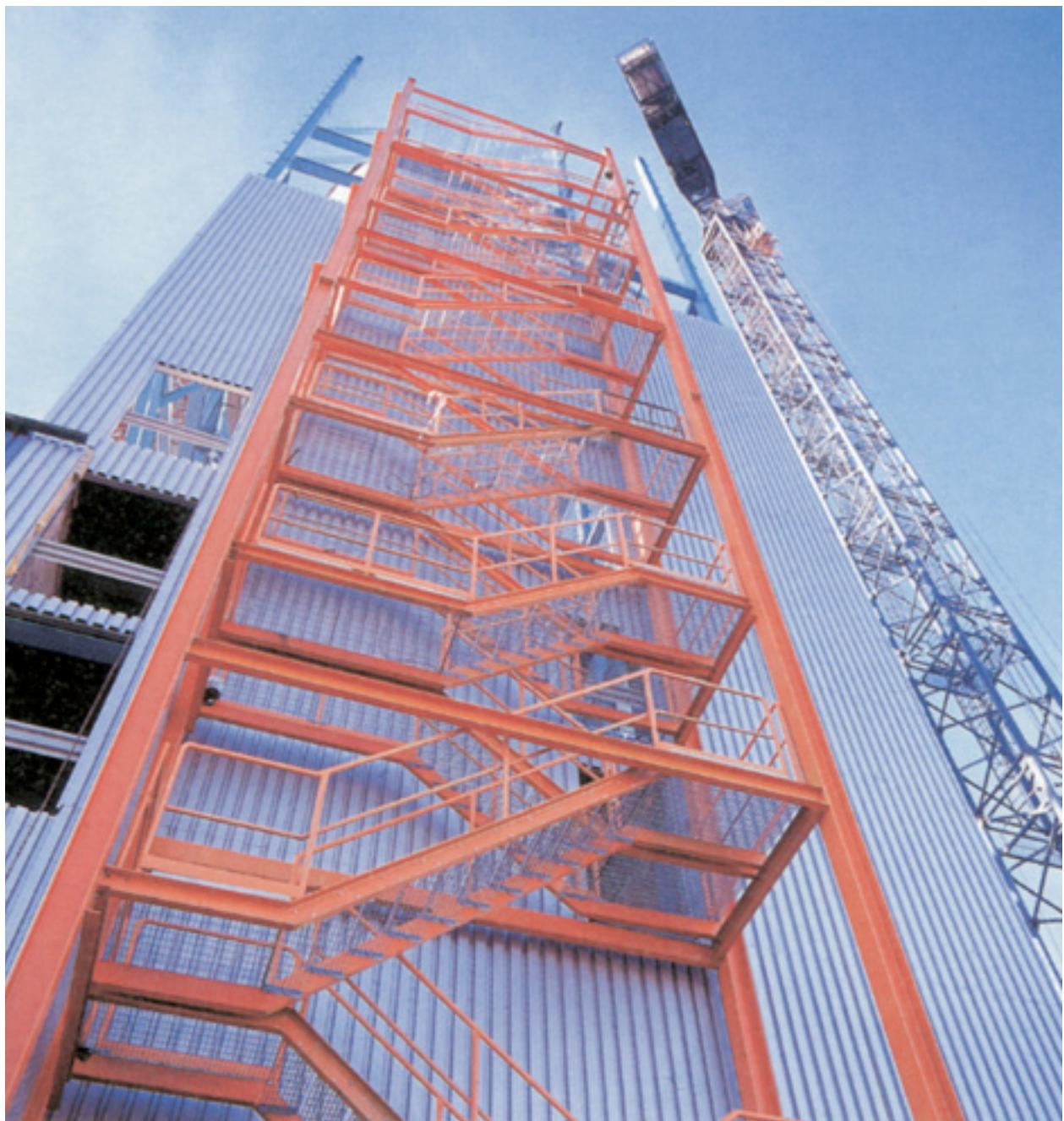
Kuvassa tyypillinen suoraporrastorni. Porras on varustettu vakiomallisella teoli-suuskaiteella rililä askelmin ja tasoin. Tasojen kaiteissa potkulistat. Torni tukeutuu kulmiin asennettuihin teräspalkkeihin.
